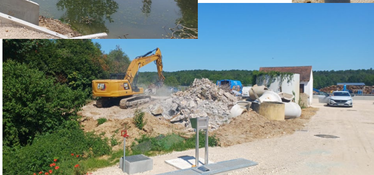
Démolition de l'ancienne station d'épuration (26/05/2026)
