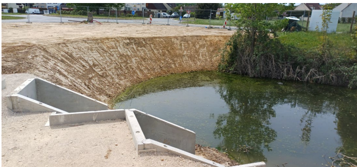
Comblement de l'ancien bassin d'orage
