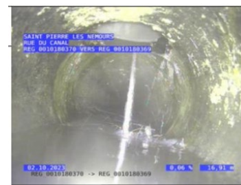
Rue du canal, à Saint-Pierre-Lès-Nemours
