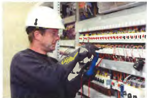
OPERATION DE MAINTENANCE SUR UNE ARMOIRE ÉLECTRIQUE
