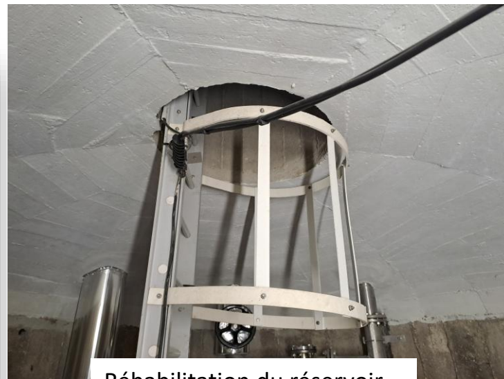
Réhabilitation du réservoir d'Herbeauvilliers à Buthiers
