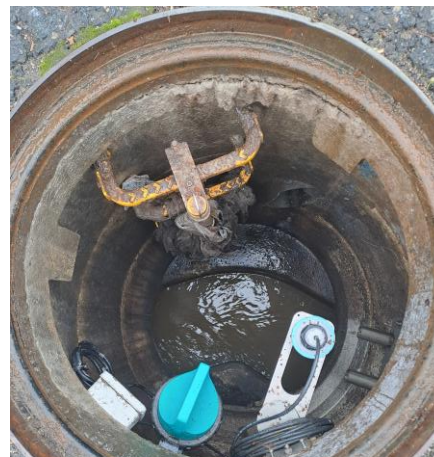
Mise en conformité de la mesure du débit du bypass (A2) situé en amont immédiat de Nemosia
