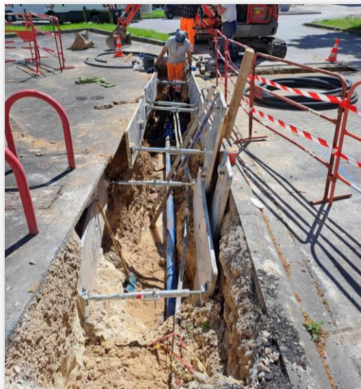
Abandon d'une canalisation publique sous les magasins du clos Saint Jean à Saint-Pierre-Lès-Nemours
