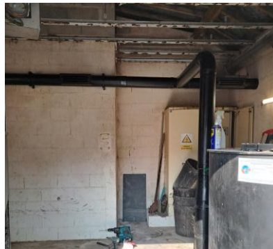
Amélioration de la ventilation du local du dégrilleur du PR Gymnase, à Nemours
