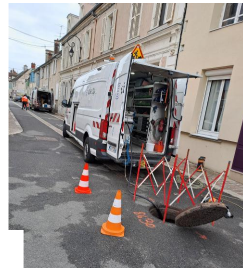
Travaux de réhabilitation du réseau d'eaux usées par l'intérieur (fraisage, pose de manchettes) sur Nemours et Bagneaux sur Loing
