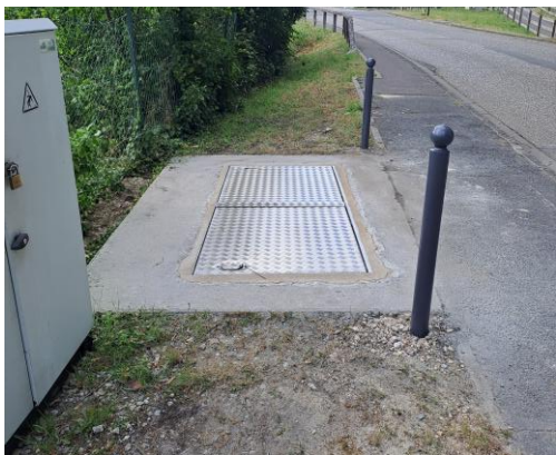
Renouvellement des plaques d'accès des postes de relevage (PR) Pasteur et Thiers à Nemours + équipements/armoires électriques PR Pasteurs
