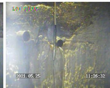
Barbacanes à 10,75 m de profondeur
