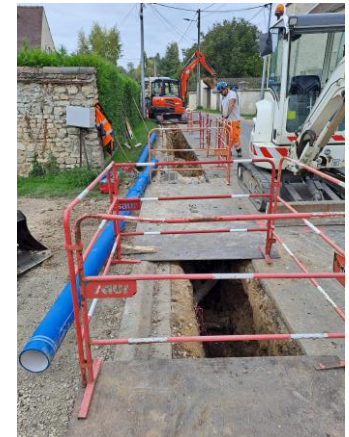
Phase 1 : renouvellement de la canalisation – 15/10/25
