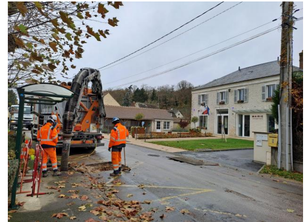
Phase 2: suppression canalisation en doublon – 19/11/25 – utilisation d'une aspiratrice excavatrice devant la mairie de Faÿ-Lès- Nemours
