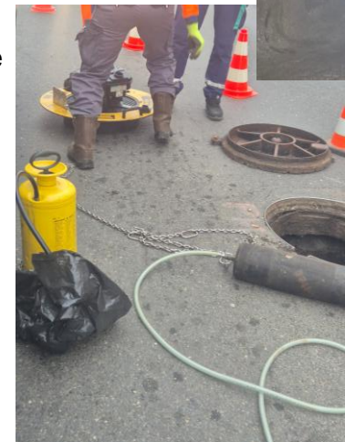
Photos de la réalisation d'un essai fumigène sur le réseau d'assainissement
