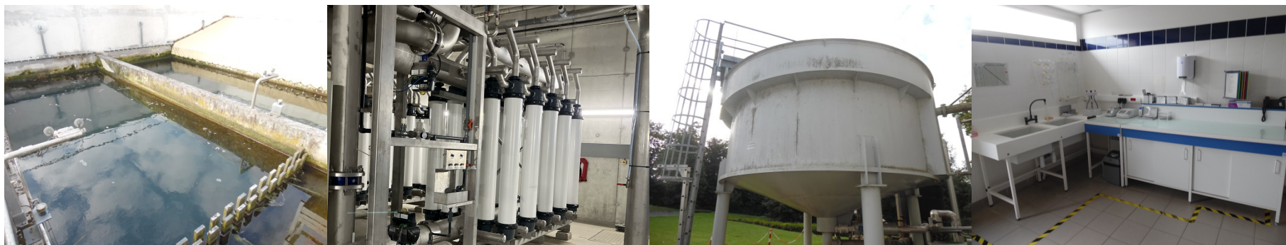
Figure 1 - UTEP Les Fontaines - Saint-Pierre-lès-Nemours
