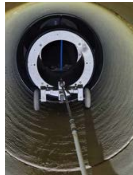
Pose d'une manchette inox avec un joint EPDM par un robot.
