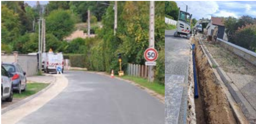
Photos du chantier
