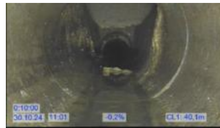
Fissure circonférentielle ouverte
