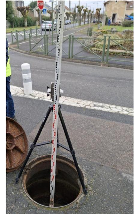
*Intervention de 3Deau le 5 février, afin de mesurer la géométrie (côtes, diamètre, pente, etc.) du bypass pour établir grâce à une modélisation hydraulique une loi hauteur / débit.*
