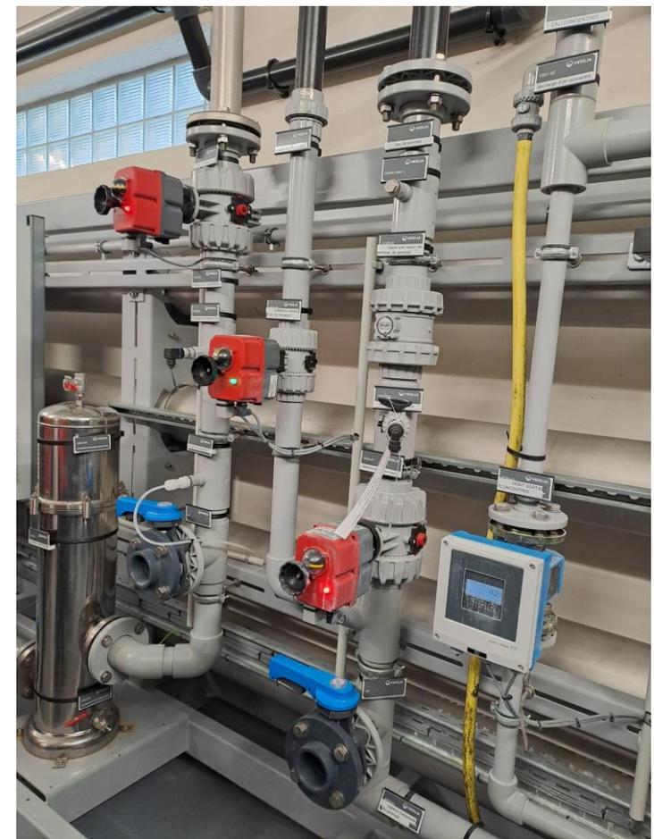
*Skid avec 3 filtres membranaires OIBP pour une capacité de traitement de 15 m<sup>3</sup>/h*
